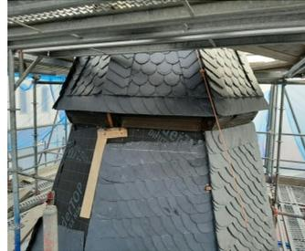
Der untere Bereich des Turms wurde in „altdeutscher Einfachdeckung“ wiederhergestellt. Der obere Bereich bekam die „Coquette-Deckung“, die der Biberschwanzdeckung bei Ziegeln ähnelt.
